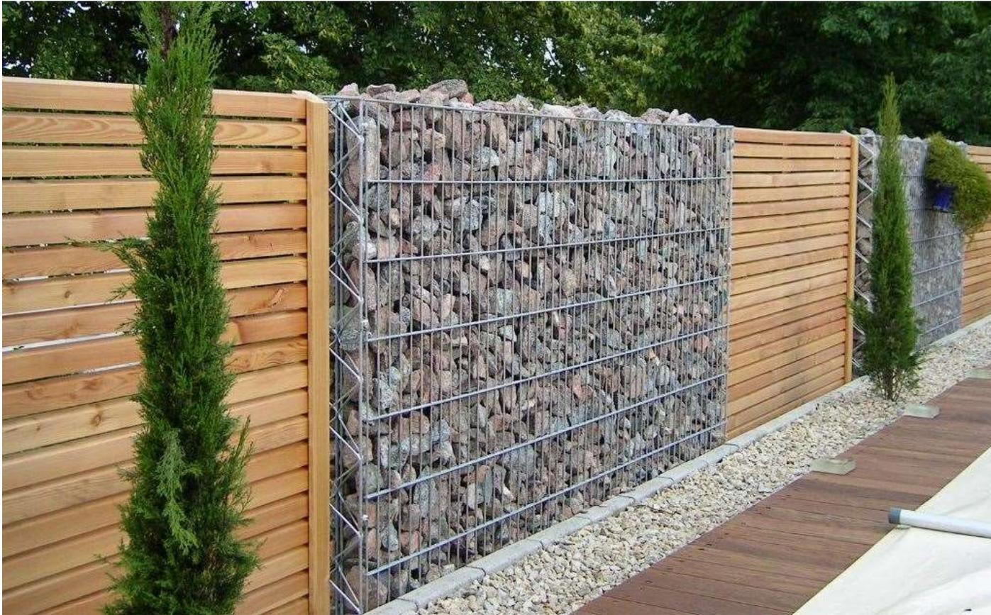
Les gabions sont des grillages métalliques comportant des mailles de 4,5 mm lesquelles sont distancées de 3 pouces. Ces grillages sont disposés en forme de boîtes puis fixée au sol par des tubes métalliques coulés dans le béton. Les boîtes qu'ils forment sont ensuite remplies avec de la roche de 3 à 6 pouces de diamètre. Ces installations sont solides, durables et traités contre la rouille.
