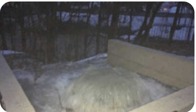
Figure 37 | Débordement d'eaux usées
