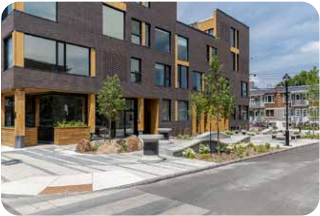
Figure 39 | Bâtiment mixte à échelle humaine
