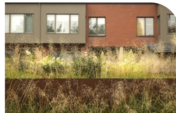
Toiture végétalisée (Photo : Rose architecture)
