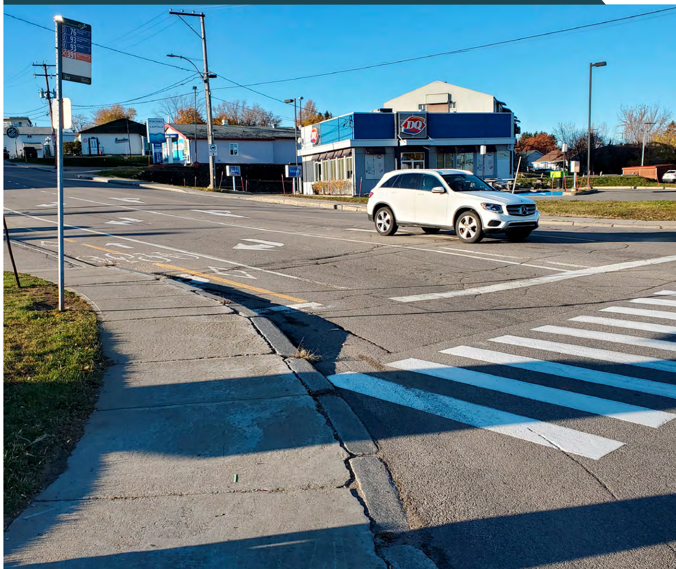
FIGURE 2. Trottoir en béton de 1,8 m avec joints de dilatation - Intersection rue Notre-Dame et boul. Wilfrid-Hamel
