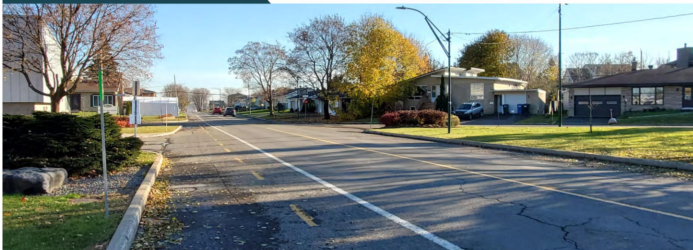
FIGURE I4. Absence de trottoir - rue Turmel
