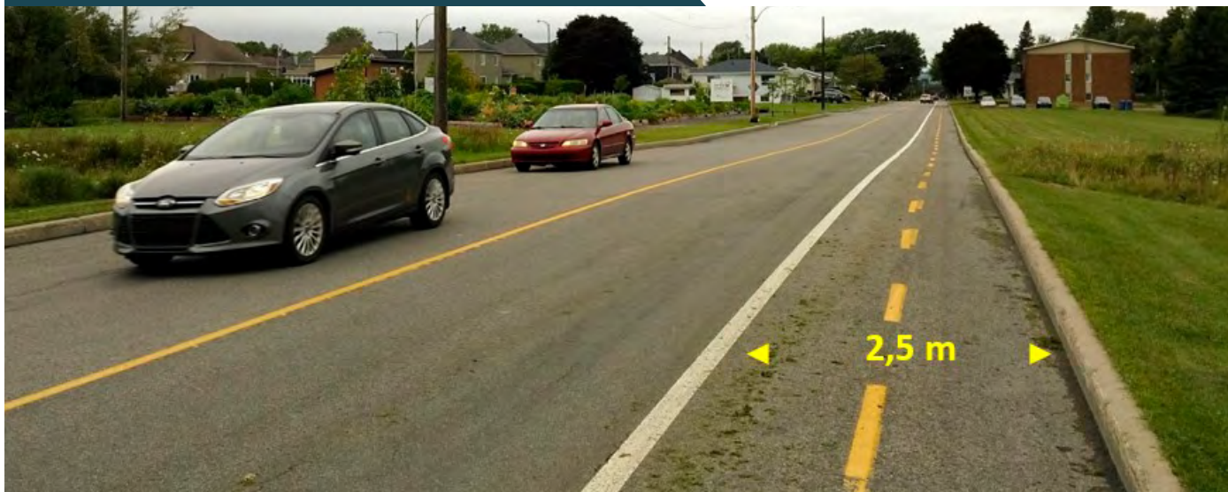
FIGURE 27. Piste cyclable bidirectionnelle non conforme – rue Turmel
